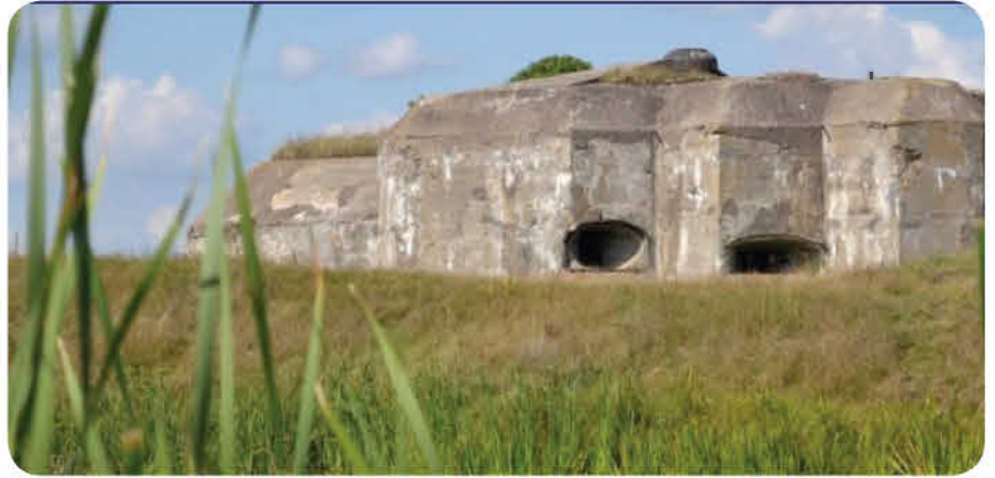
➡ Przygotowujemy dokumentację projektową niezbędną do odbudowy Fortu II Zarzecznego (w trakcie realizacji) — etap I i etap II 💰 1,34 mln zł, dotacje 1,3 mln zł
