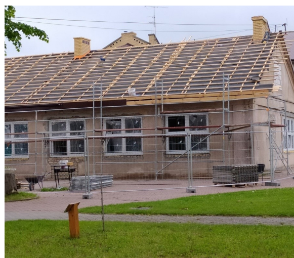
Termomodernizacja starej części szkoły
