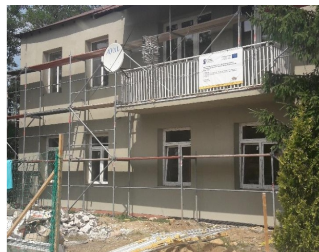
W tej chwili trwa termomodernizacja głównego budynku Centrum Edukacji i Readaptacji
