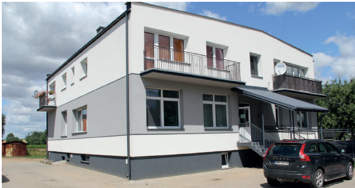
Gminny Ośrodek Zdrowia w Krypnie po termomodernizacji
